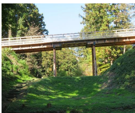
本丸堀の橋台
