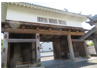
移築された大手門
