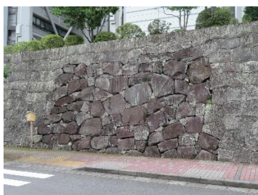
時代によって石垣の積み方が異なっている
