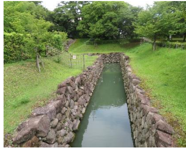
本丸堀と二の丸堀の連結水路(右の本丸堀の水を外に流す、物流として使用など)
