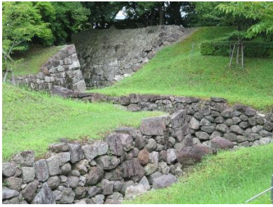
本丸堀と二の丸堀の連結水路(右の本丸堀の水を外に流す、物流として使用など)
