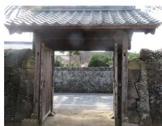
石垣の積み方に特徴がある(石垣を登ると上の石が落ちる)
