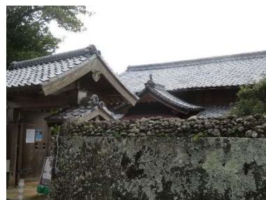
石垣の積み方に特徴がある(石垣を登ると上の石が落ちる)
