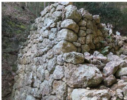
三の城戸は7m 近くの高さまで積み上げられ水門の機能もしている
