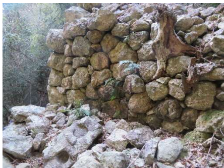
三の城戸は7m 近くの高さまで積み上げられ水門の機能もしている
