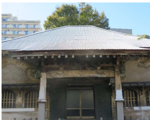
本殿(屋根はトタン葺き)
