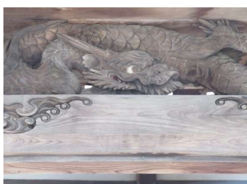
本殿上には立派な龍の彫刻
