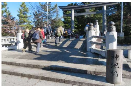
太鼓橋となっている神橋
